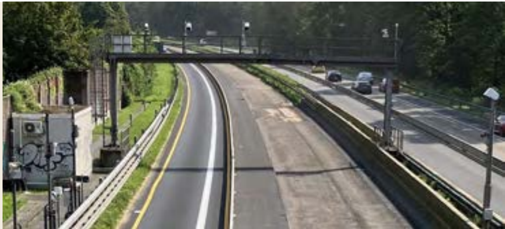
Blick auf das Prüf- und Testfeld A4 während der Fahrbahndeckensanierung
