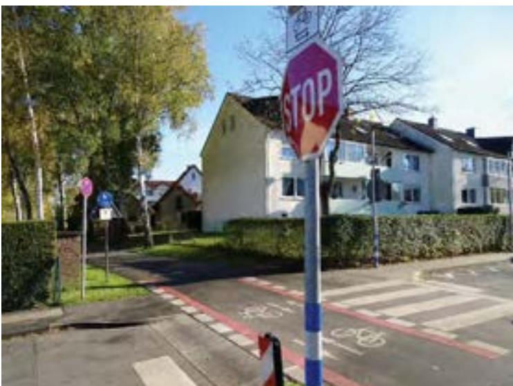
Bevorrechtigte Kreuzungssituation zwischen Rad- und motorisiertem Verkehr in Detmold
